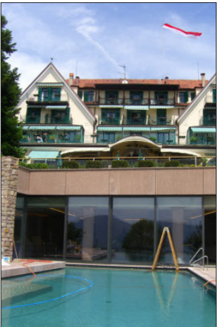
Parkhotel Holzner, Oberbozen, Einbau Schwimmbad.
